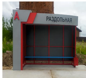
Установка остановочных павильонов
